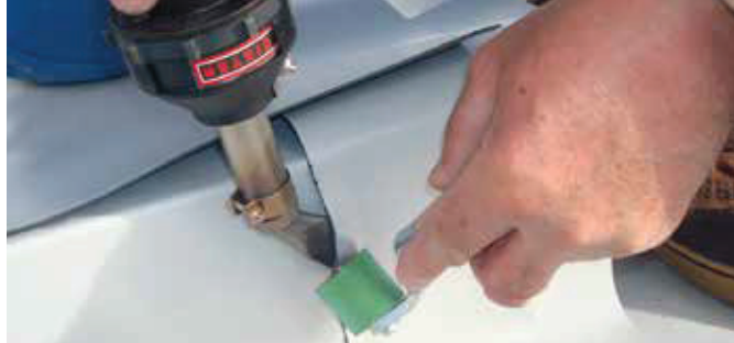
HOT JET S met hoekmondstuk tijdens het lassen op een T-stuknaad op het dak.
